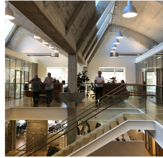
● Papirhal på den tidligere Dalum Papirfabrik er omdannet til moderne kontorer ved at indskyde et dæk og lave vinduesåbninger i facaderne. De gamle rytterlys og betonkonstruktionen giver karakter. Arkitekt C.F. Møller.
