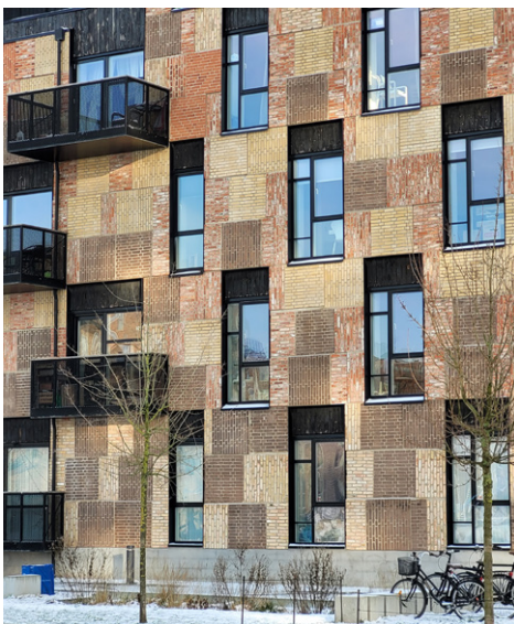
Genanvendelse af murflader fra byggeri, hvor murstenene ikke kunne skilles ad enkeltvis. Ressourcerækkerne i Ørestaden af Lendager.
