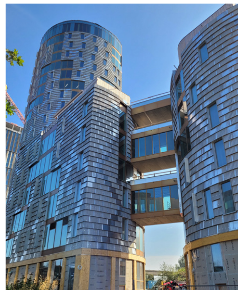
Kontorbyggeriet "Træ" i Aarhus har facader af genbrugte og fejlbehæftede plader, som giver facaden struktur og stofflighed. Lendager.
