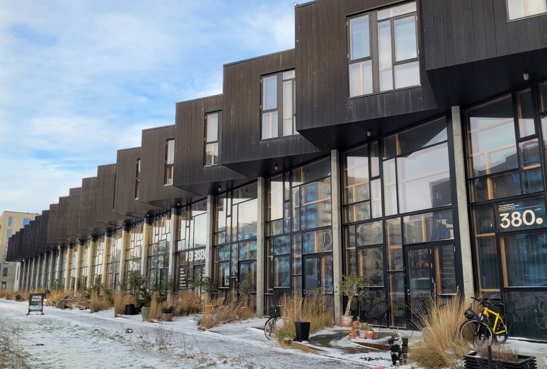
I Ørestaden er "Upcycle Studios" af Lendager er bygget af genbrugsmaterialer fra betonen, som indeholder tilslag fra brugt beton, over træbeklædningen til vinduerne og indvendig træbeklædning af vægge og gulve.
