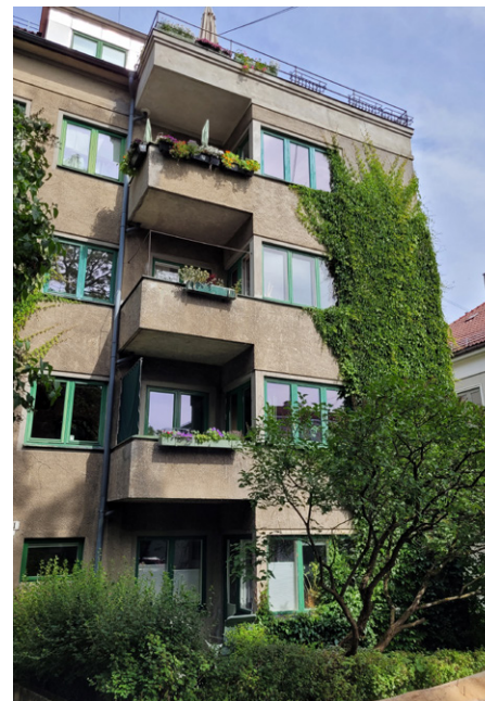
Fællesarealer foran og bag bebyggelsen, altaner sammen med karnapper, tagterrasse til øverste etage samt facadebegrønning. I ejendommen i Oslo får man det hele.
