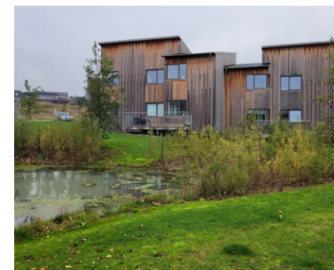
● Almen boligbebyggelse i Seest nær Kolding, hvor husene løftes over jorden på søjler og regnvand ledes til et bassin i det grønne område mellem husene. Arkitekt er Dissing + Weitling.
